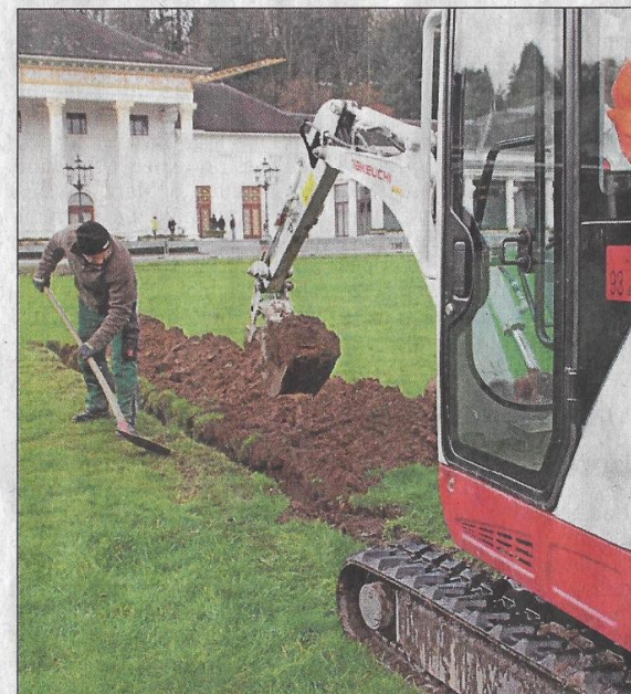
Im Kurgarten werden die Gräben für die neuen Leitungsrohre ausgebagert.
